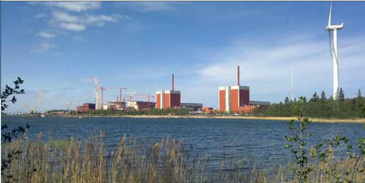
Olkiluoto NPP, Finland
