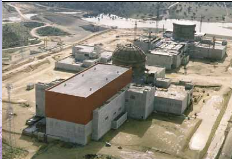
Construcción de la Central Nuclear de Valdecaballeros I y II
