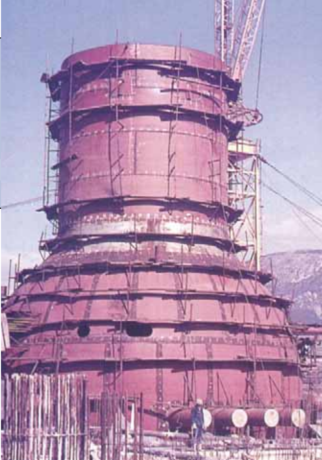
Construcción de la Central Nuclear de Santa María de Garoña
