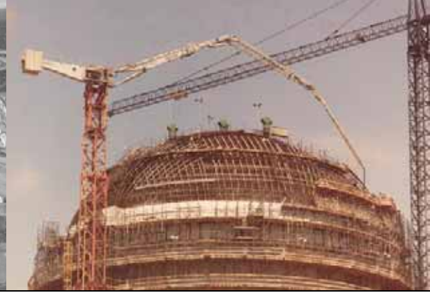
Construcción de la Central Nuclear de Trillo I
