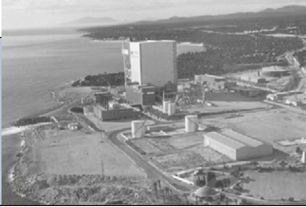
Central Nuclear de Vandellós I
