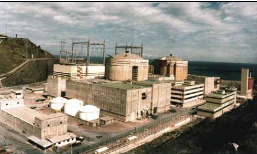
Construcción de la Central Nuclear de Lemóniz I y II
