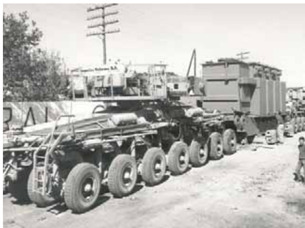
Transporte utilizado en la construcción de Zorita
