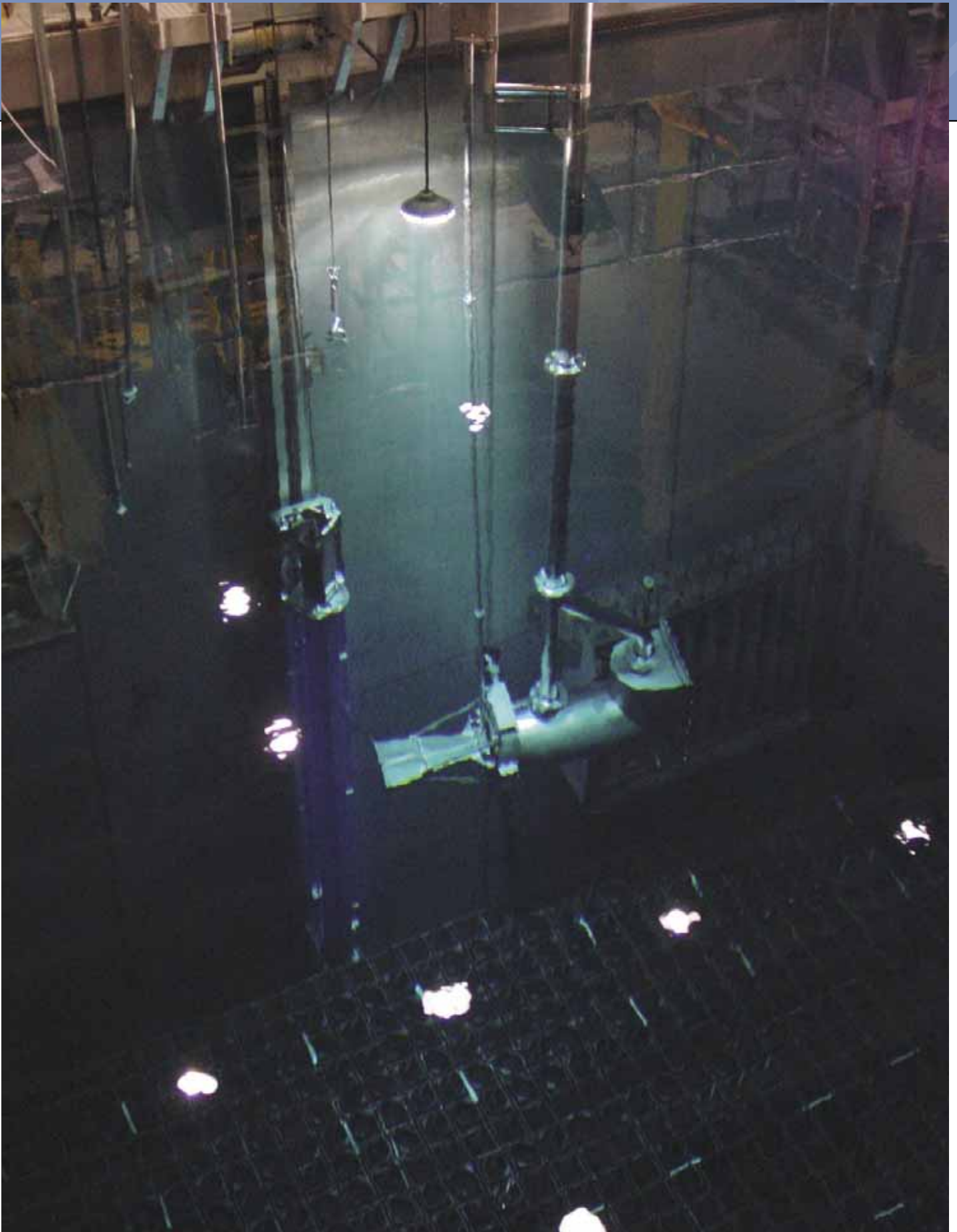
Piscina de combustible usado de una Central Nuclear
