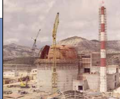
Construcción de la Central Nuclear de José Cabrera
